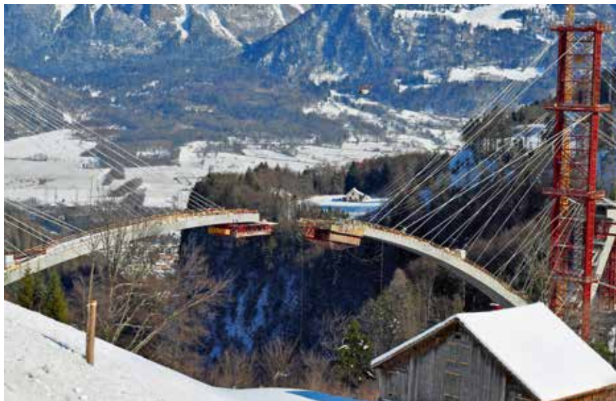
Bau der Taminabrücke
